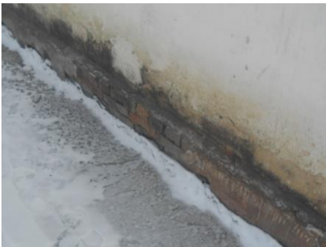
Фото 4. Разрушение штукатурки цоколя, выветривание швов кладки стен из кирпича.
