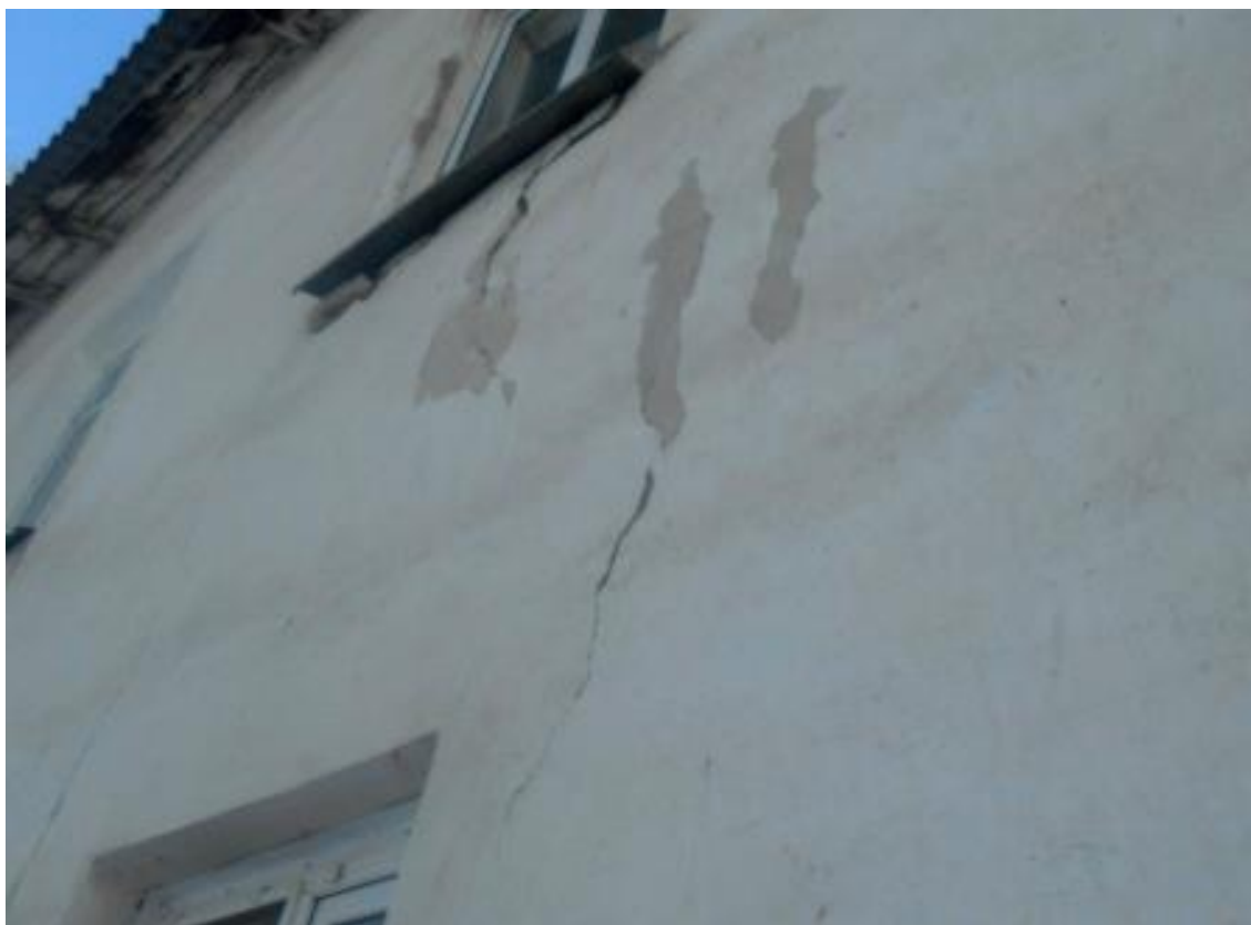
Фото 6. Трещины в штукатурке.
