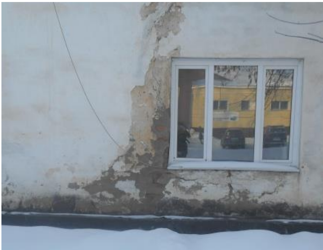
Фото 5. Разрушение штукатурки фасада.
